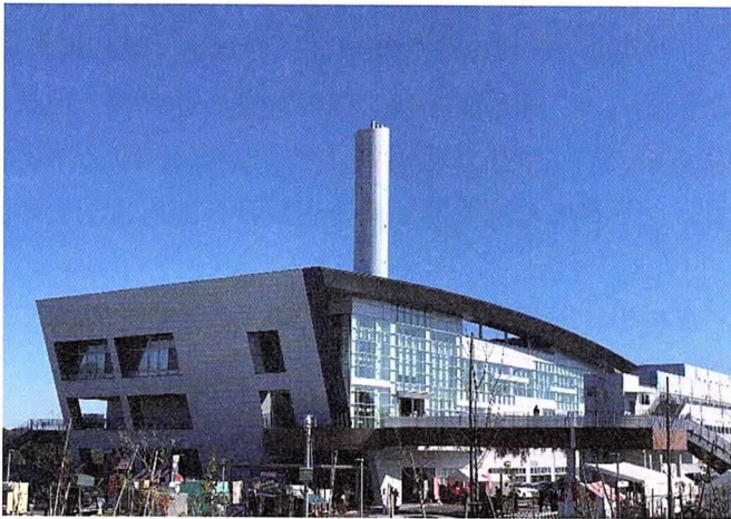
＜町田市バイオエネルギーセンター＞
