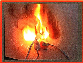
プラグ・コンセントの火災【トラッキング火災再現実験写真】
